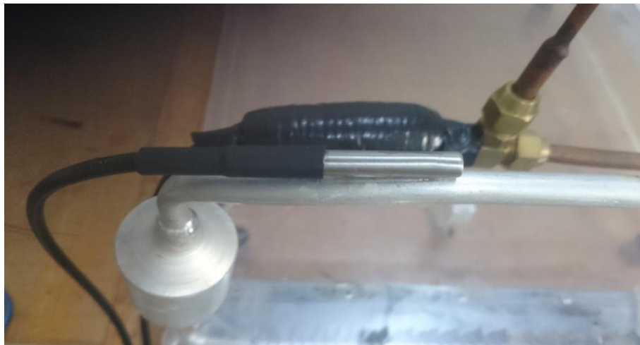
FIGURA 18- Sensor de temperatura instalado no evaporador.
