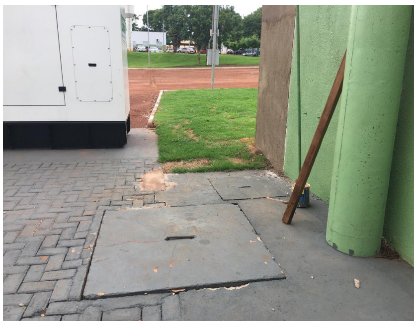
Figura 2 – Caixa de passagem existente II.
