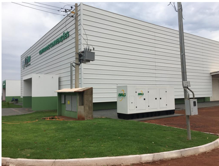
Figura 4 – Local de instalação do poste
