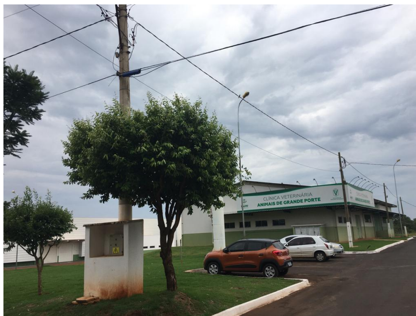
Figura 8 – Postes 3 e 4 existentes.
