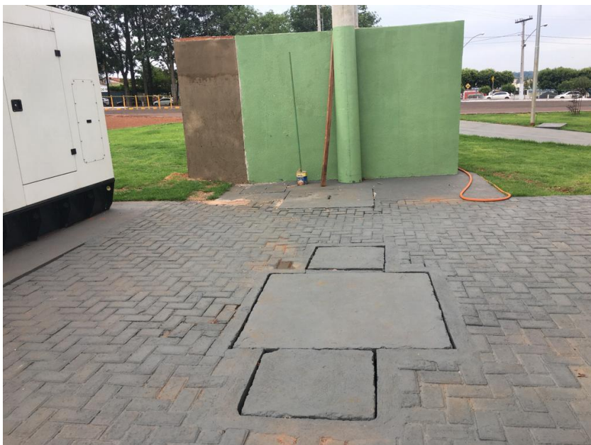
Figura 1 – Caixas de passagem existente I
