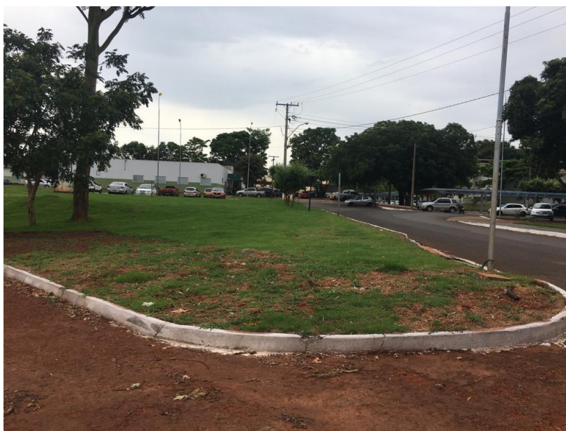
Figura 5 – Local de instalação do Poste 2.
