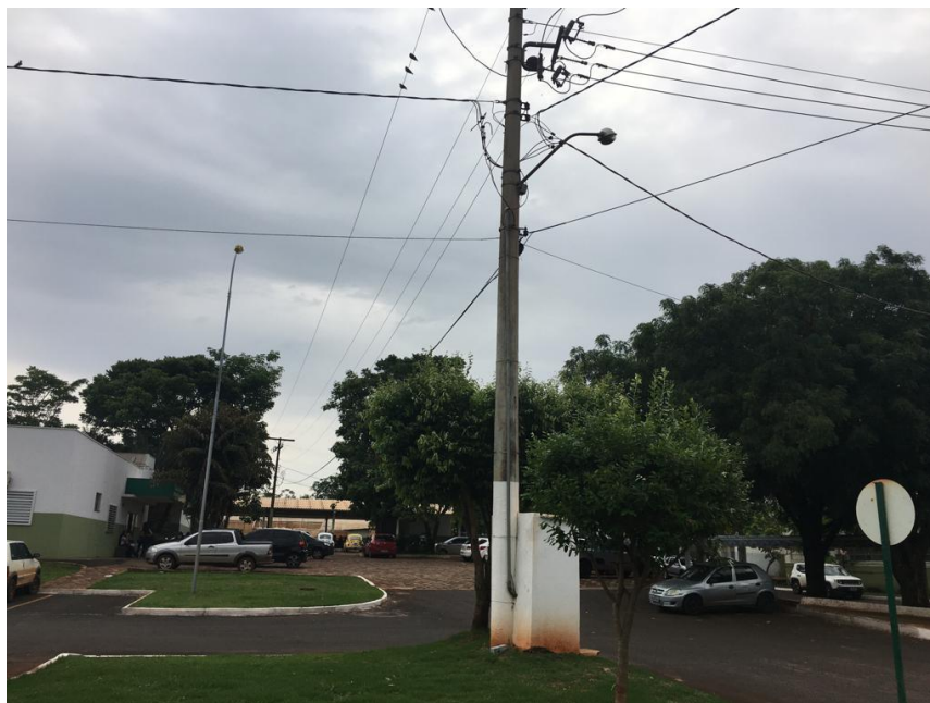
Figura 7 – Poste 3 – poste circular existente.
