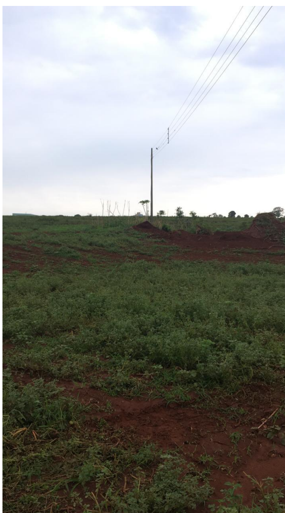
Figura 4. Poste existente – Final da rede aérea e início da rede subterrânea.
